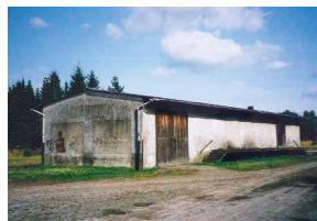
Schuppen der Genossenschaft; Er stand bis 2002 auf dem hin- teren Teil des Bahngeländes Foto: Carsten Tegethoff
