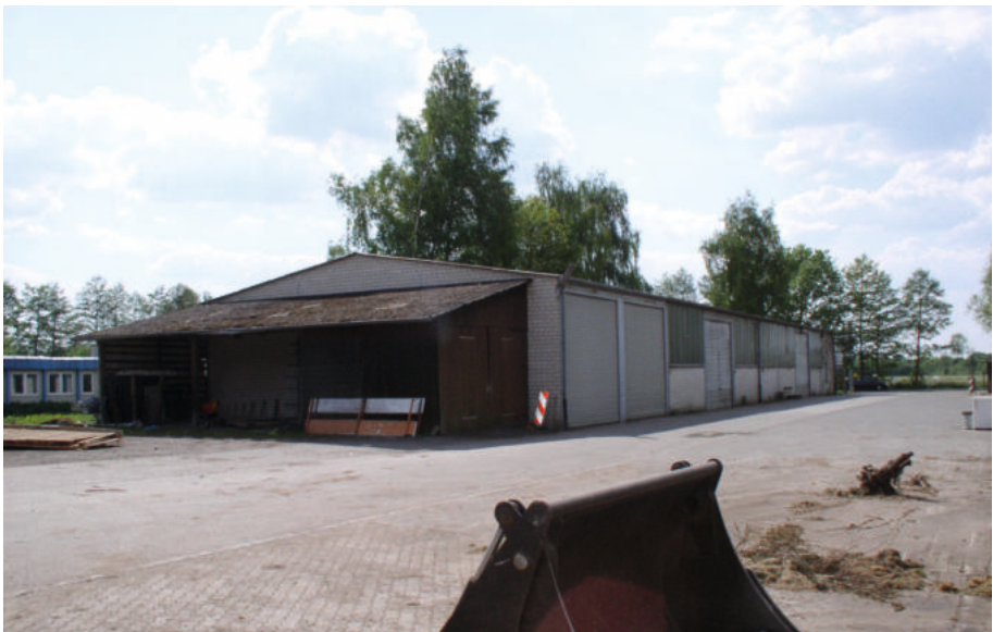
Alter Bauhof auf dessen Betriebsgelände sich heute der Glockenblumenweg befindet (Foto 2008: Carsten Tegethoff)
